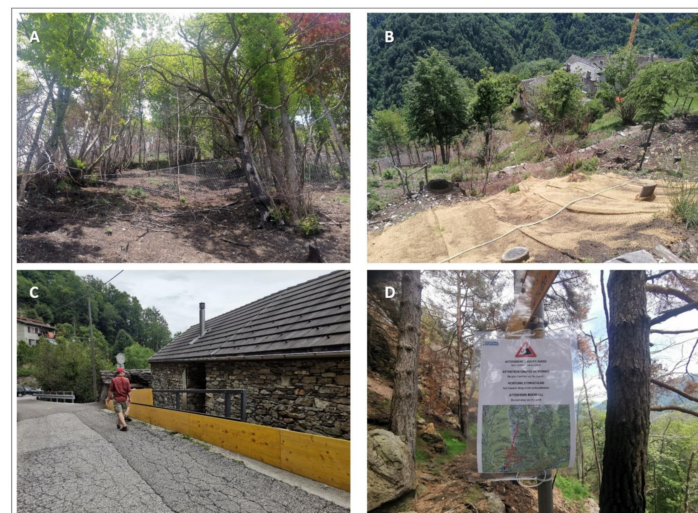
Abb. 7: Management des post Waldbrand Risikos. Sofortmaßnahmen im Bereich des Katastrophengebiets Verdasio. (A) Steinschlagschutz, (B) Erosionsschutz, (C) Schutz vor Hangmuren/Wasser, und (D) Warnschilder (Photos von S. Melzner).
