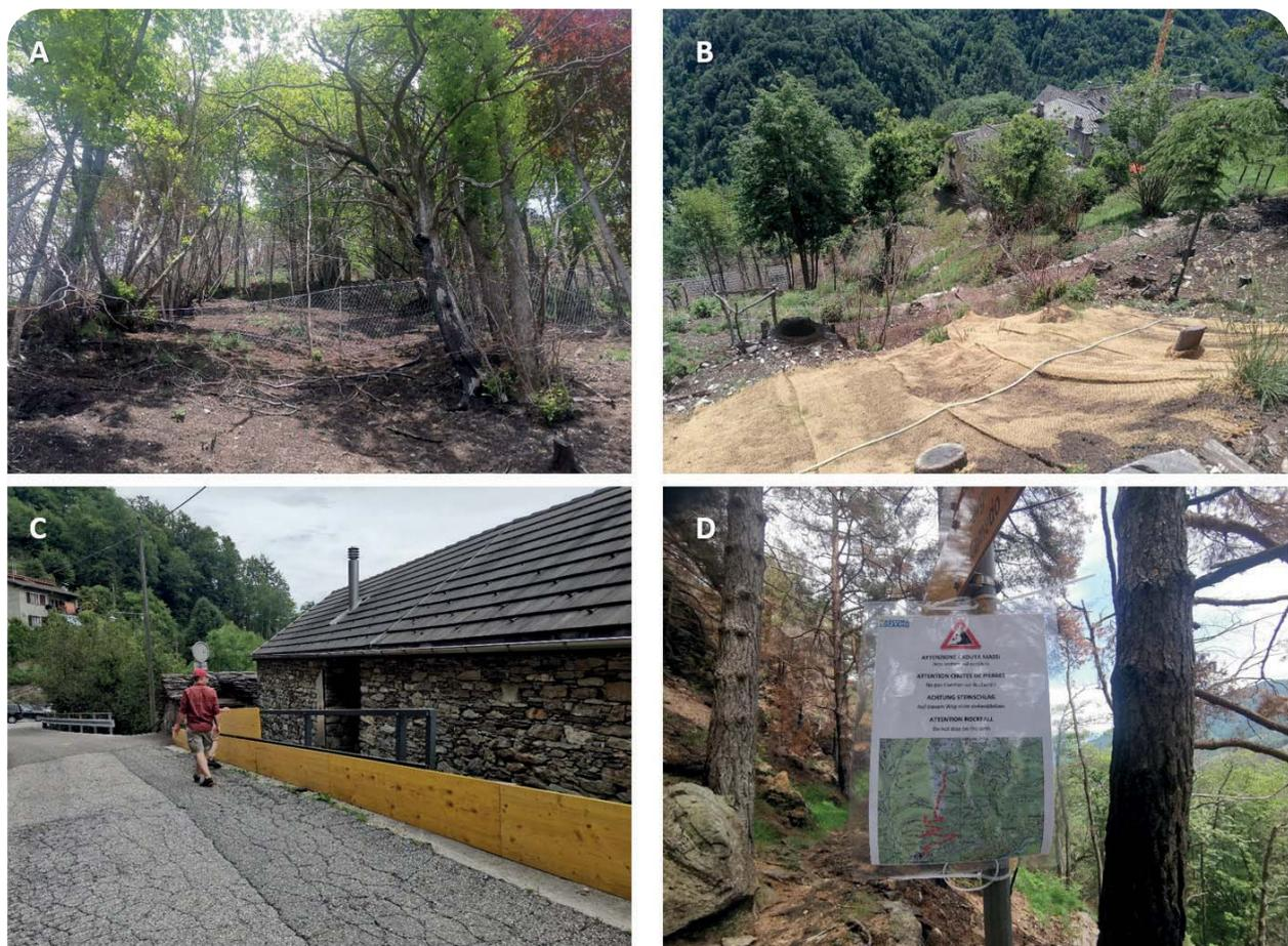
Abbildung 7: Management des post Waldbrand Risikos. Sofortmaßnahmen im Bereich des Katastrophengebiets Verdasio. (A) Steinschlagschutz, (B) Erosionsschutz, (C) Schutz vor Hangmuren/Wasser, und (D) Warnschilder (Photos von S. Melzner).
